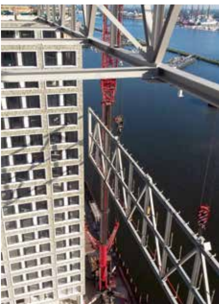
5. De spanten zijn per schip vervoerd en ingehesen.
