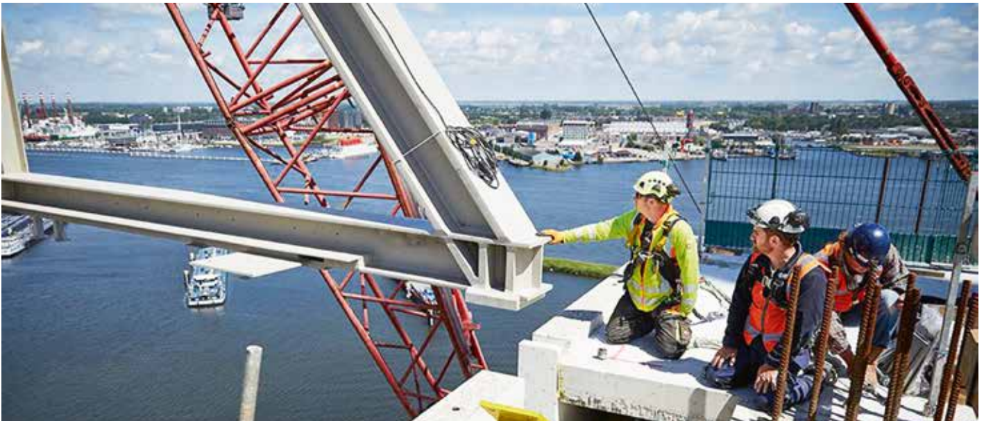
9. De vakwerkspannten worden uitsluitend verticaal opgelegd op de torens.
